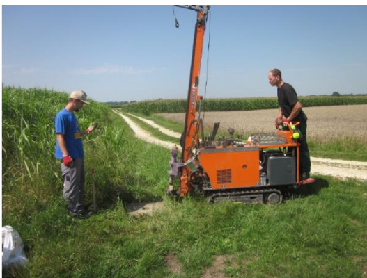
Ausführung einer Rammkernsondierung
